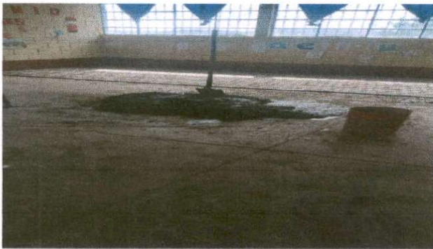
Foto3: Sustrucción de piso ceramico auala aula No. 3
