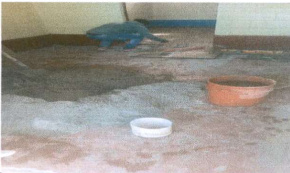
Foto 5: Sustrucción de piso ceramico Dirección y bodega
