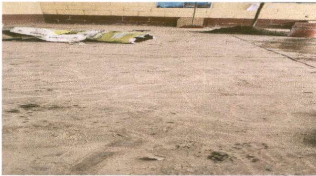
Foto1: Sustrucción de piso ceramico aula No. 1
