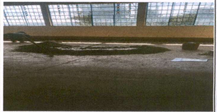
Foto 2: Sustrucción de piso ceramico Aula No. 2
