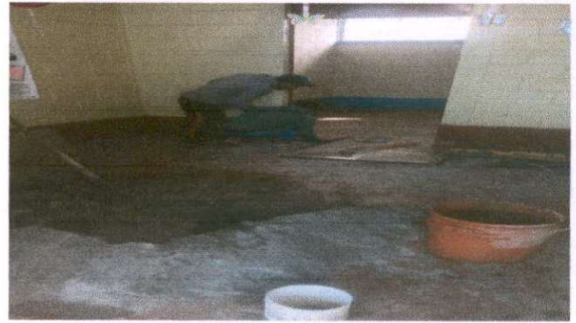
Foto 4: Sustrucción de piso ceramico aula No. 4
